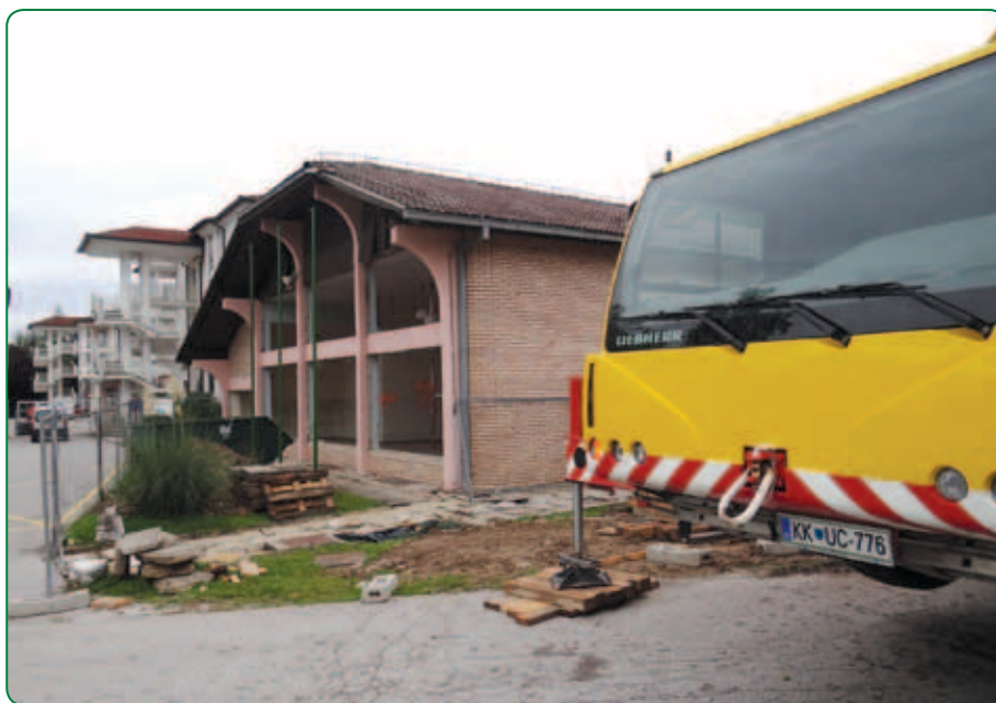
Med obnovo objekta prehrane, oktober 2012
